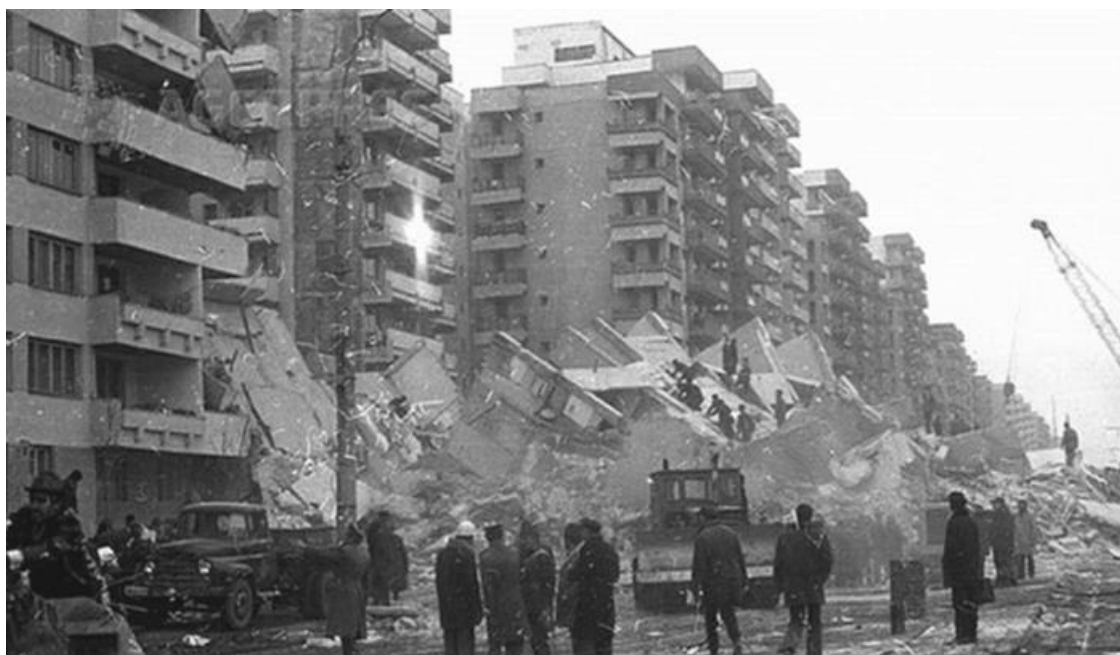
Землетрясение в Бухаресте в 1977 году
