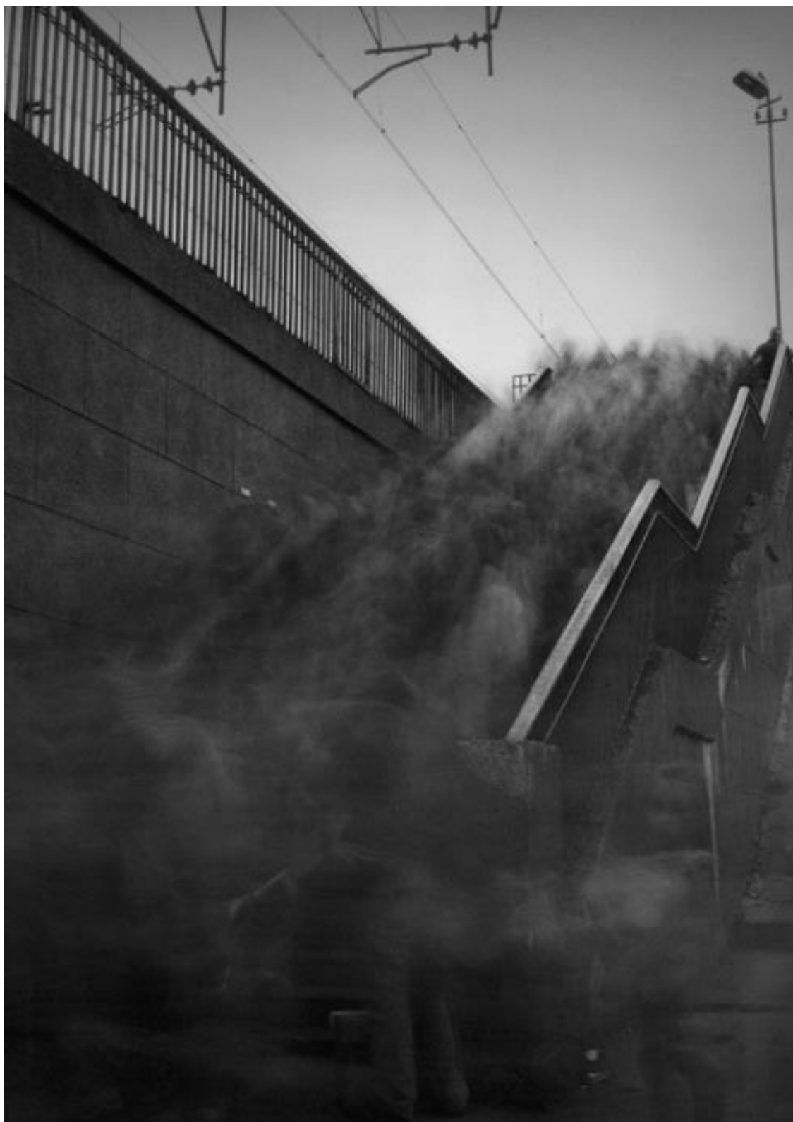
Лестница железнодорожной платформы «Ленинский проспект». Фот. Алексей Титаренко. 1994
