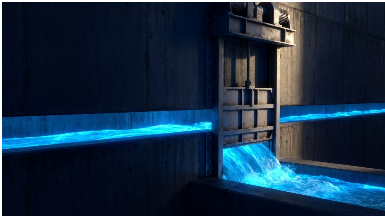
Рис. 1.1. Транзистор как управляемый илюз: положение затвора определяет силу тока.
