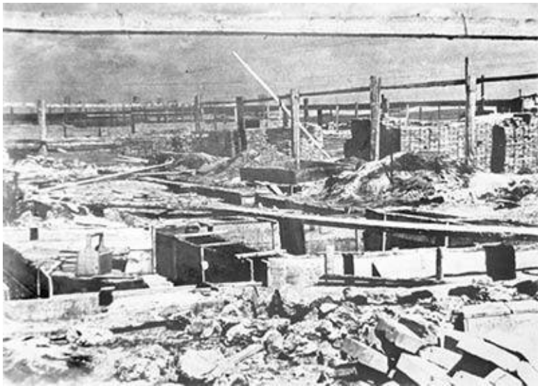
Панорама строительной площадки в 1933 году
