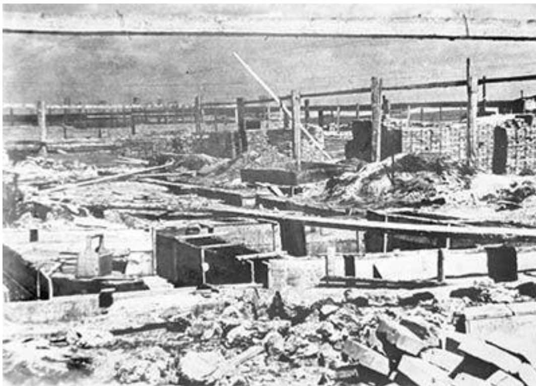
Панорама строительной площадки в 1933 году
