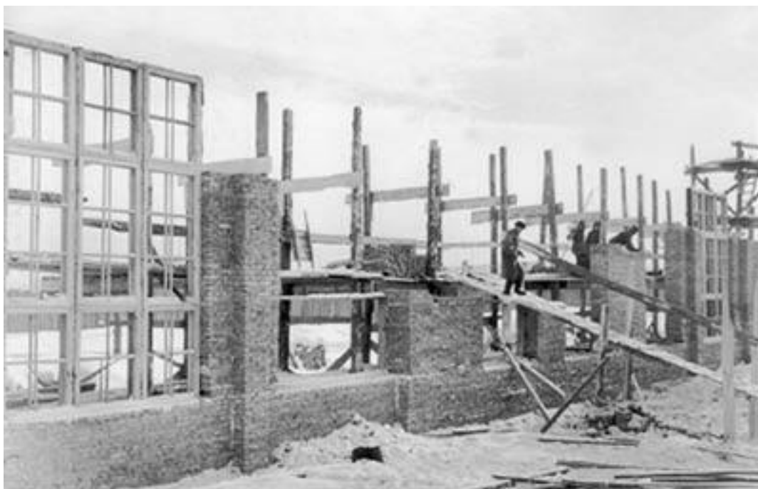
Строительство основного корпуса
