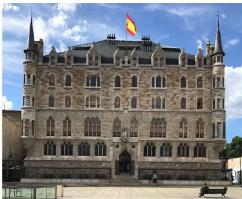
Fig. 188. Casa de los Botines.
