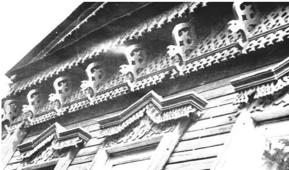
г. Бугуруслан, ул. Красногвардейская, 71 Фронтонный свес домовой постройки
