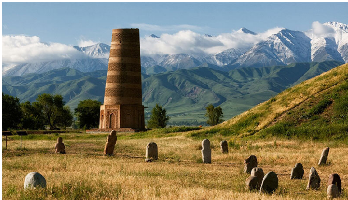
Современный вид башни Бурана после реставрационных работ в середине 70-х годов XX века
