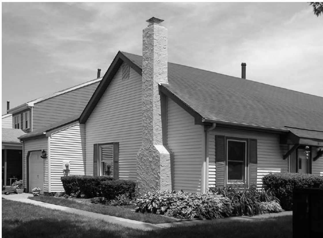
Вся теплоотдача камина за пределами здания. Фото автора.
