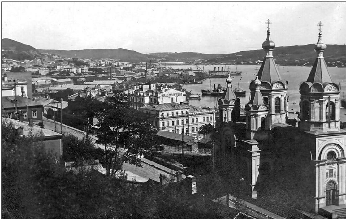
Собор Успения Пресвятой Богородицы на Светланской улице во Владивостоке (разрушен в 1938 г.)
