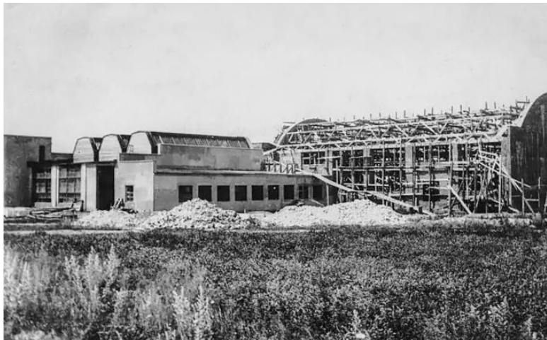
Строительство Рязанского электролампового (электро- колбового) завода, 1934 г.
