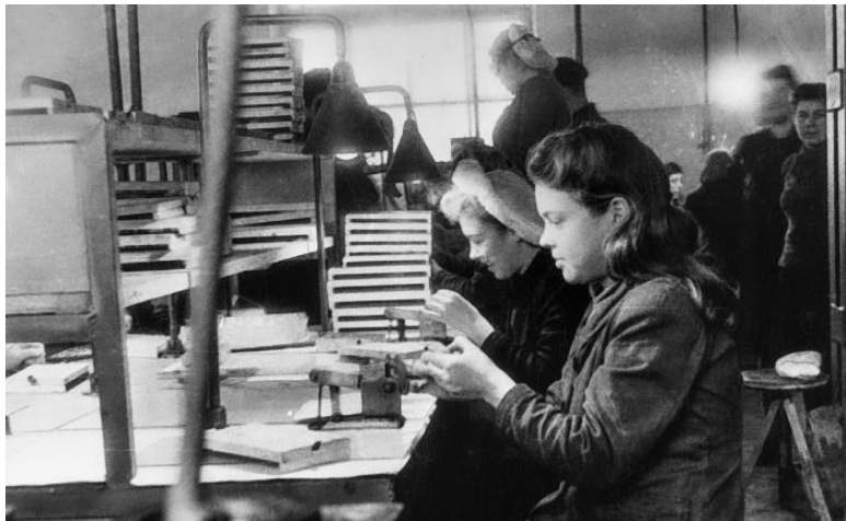
Монтажницы центра миниатюрных лампочек Рязанского электролампового завода А.Н. Смирнова и Л.П. Гусева за монтажом миниатюрных лампочек, 1948 г.
