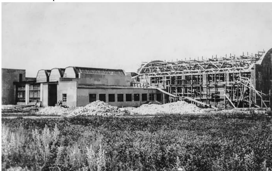
Строительство Рязанского электролампового (электроколбового) завода, 1934 г.
