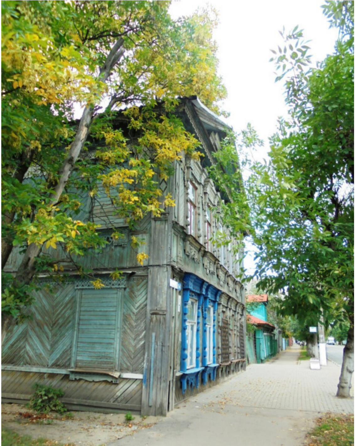
Центр. Деревянные дома Твери
