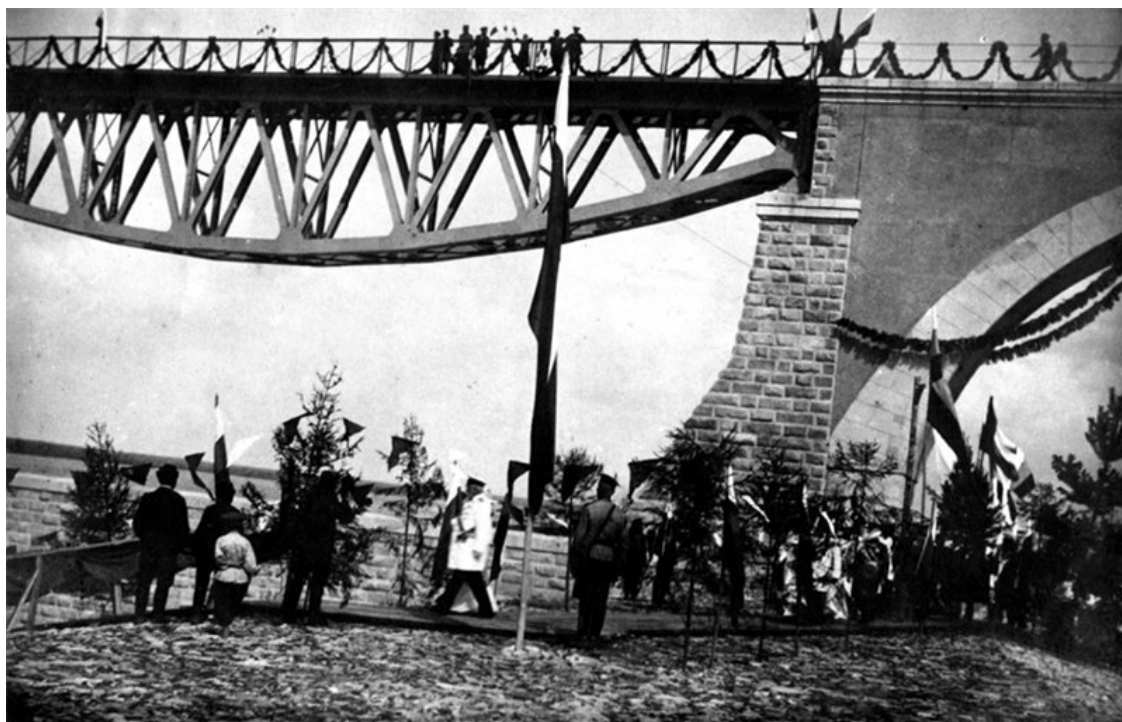
Автор неизвестен. Открытие железнодорожного моста через р. Волгу у г. Свяжска. Фотография. 1913
