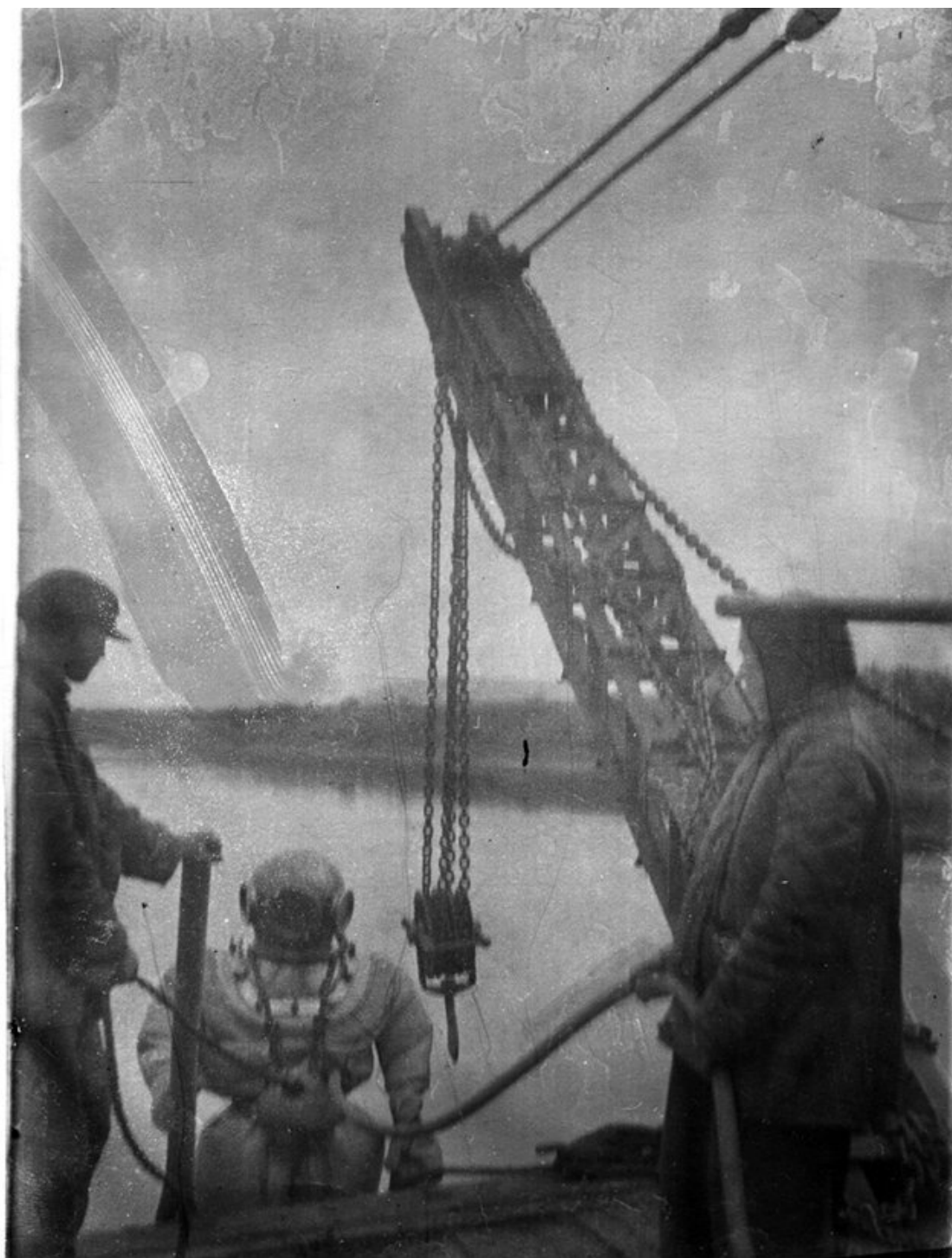
Автор неизвестен. Момент спуска водолаза в воду. Из коллекции фотографий работ по прокладке подводного телеграфно-телефонного кабеля через реки Вятку, Каму и Волгу за 1931, 1936, 1938 годы. 1936
