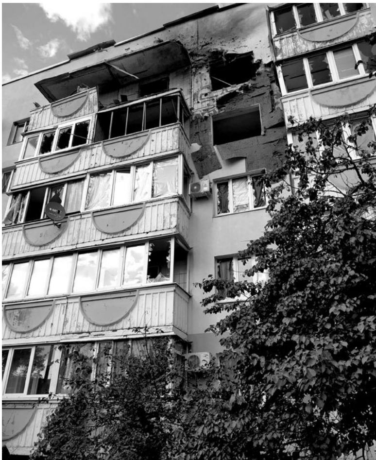
Шебекино. Дом после попадания и пожара
