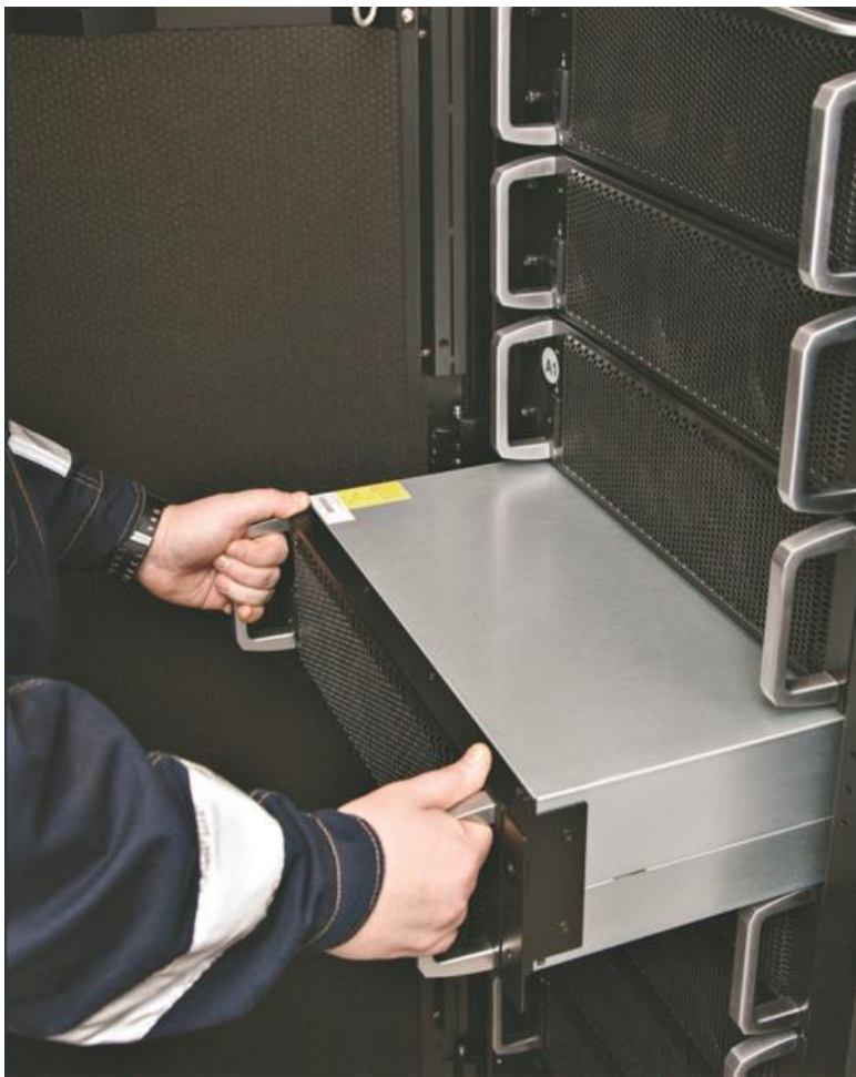
Рис. 2. Замена модуля ИБП силами дежурного электрика ЦОД
