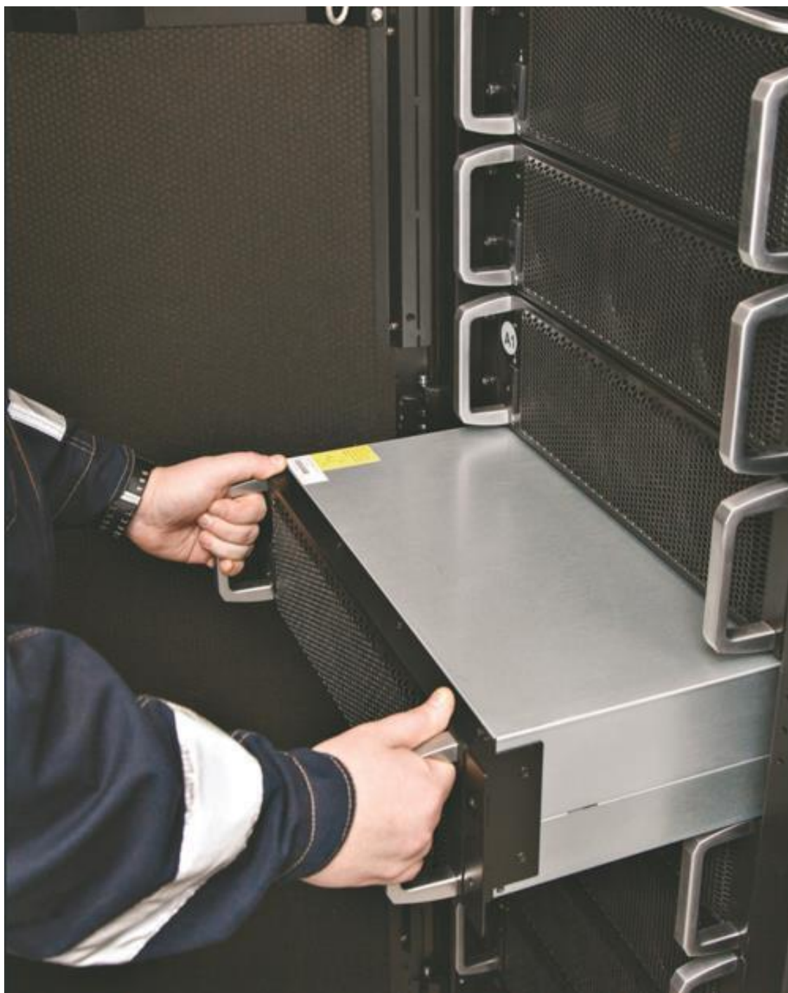
Рис. 2. Замена модуля ИБП силами дежурного электрика ЦОД
