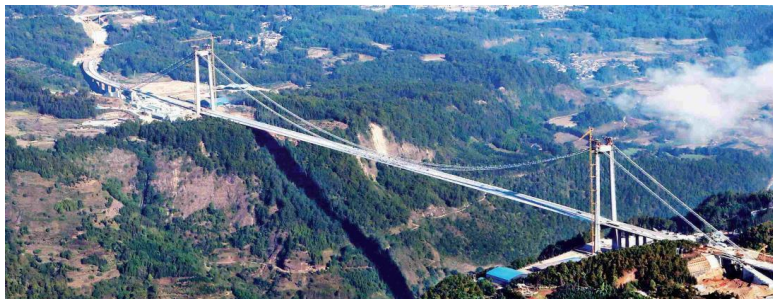
Мост Луницян, фотография сделана во время строительства
