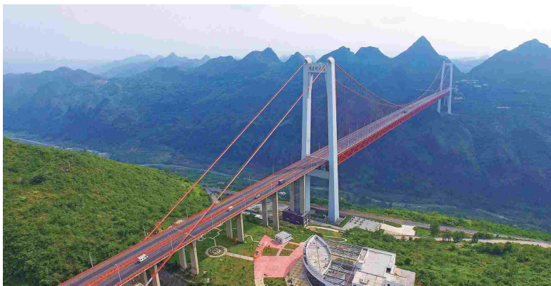
Мост через реку Балинхэ, фотографии сделаны во время строительства и после его завершения
