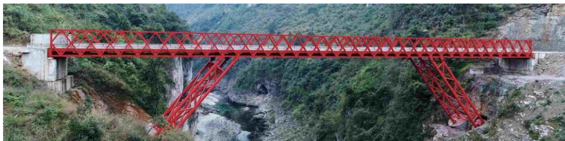
Транспортировочный мост Мяньюа
