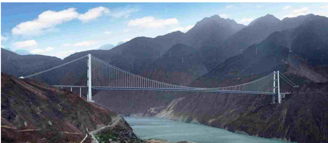
Мост Лудин, фотографии сделаны во время строительства и после его завершения
