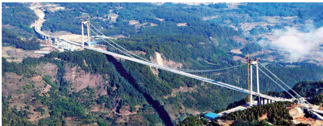
Мост Лунцзян, фотография сделана во время строительства
