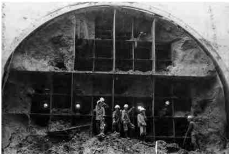
Рис. 1-37. Строительство 3-метрового экструзионного решетчатого гидравлического проходческого щита, изготовленного Цзяннаньским судостроительным заводом. Работы гидравлического проходческого щита (1982 г.)
