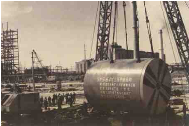
Рис. 1-40. Шанхайский собственный 64-метровый проходческий щит с гидропригрузом (1988 г.)
