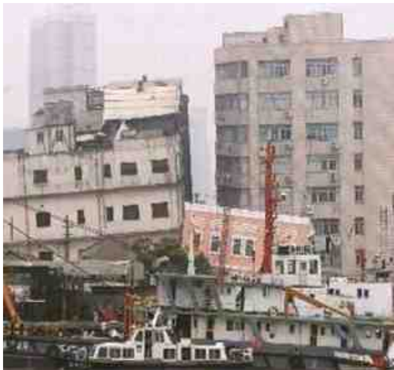
Рис. 3-15. Наклон здания
