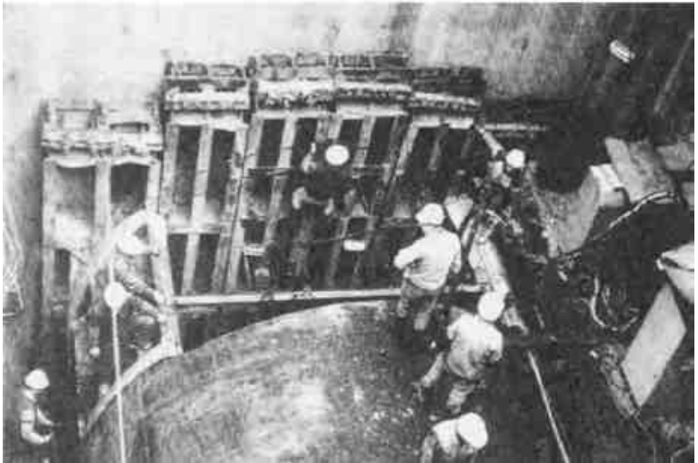
Рис. 1-33. Выкопанная вручную щитовая проходка, разработанная Шанхайским бюро городского строительства (1962 г.)
