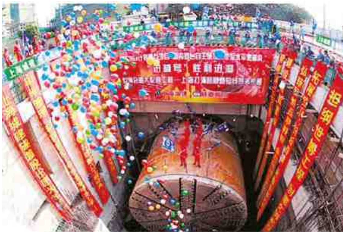
Рис. 1-51. Проходческий щит «Цзинь Юэ» успешно реализовал проект по перекладке туннеля шанхайской дороги Дапу
