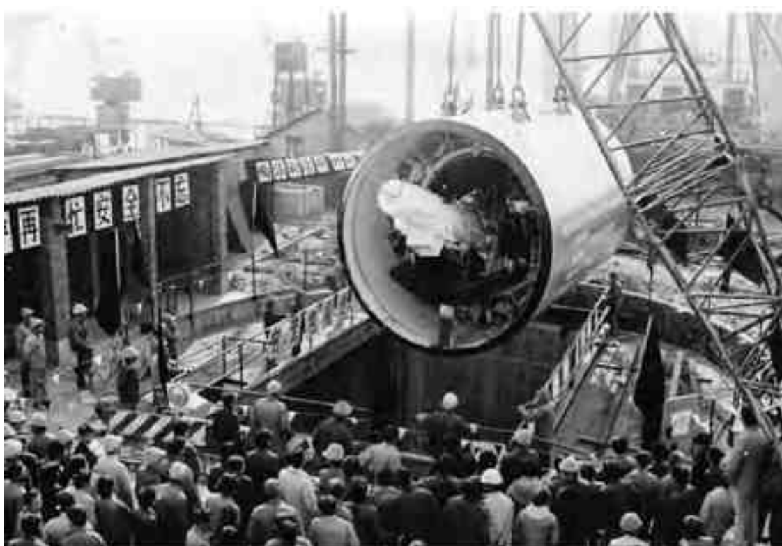
Рис. 1-39 Проходческий щит с грунтотригрозом \phi 35 м, изготовленный Шанхайским судостроительным заводом (1987 г.)
