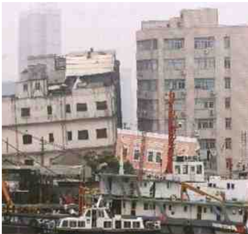
Рис. 3-15. Наклон здания
