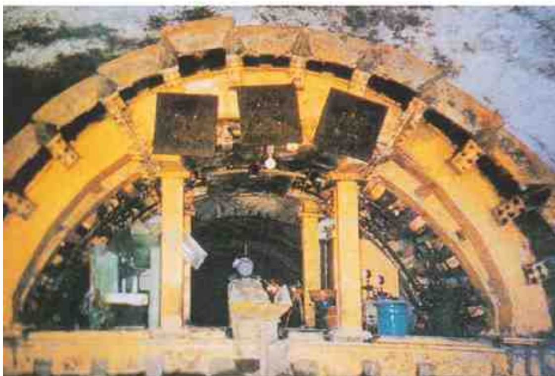
Рис. 1-38. Режущий проходческий щит (1986 г.)
