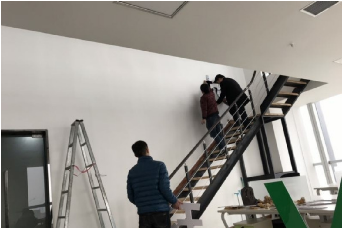
#Начало отделки офиса).
