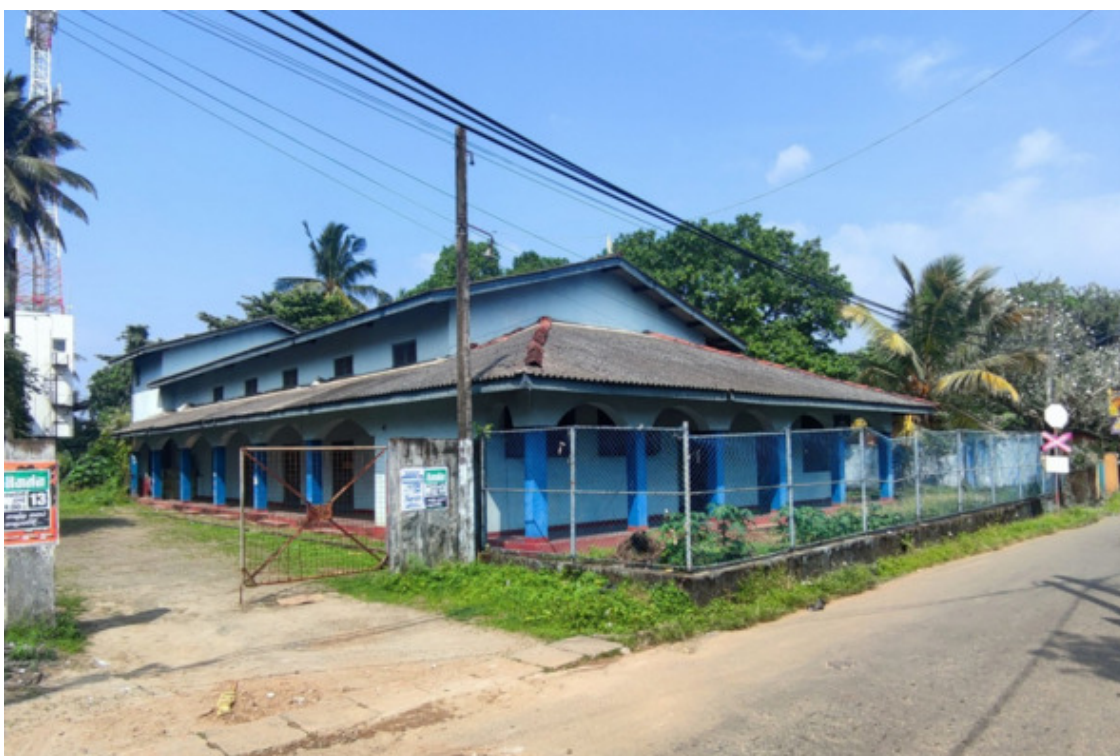
Старое здание (Maha Vihara Rd, 26)
