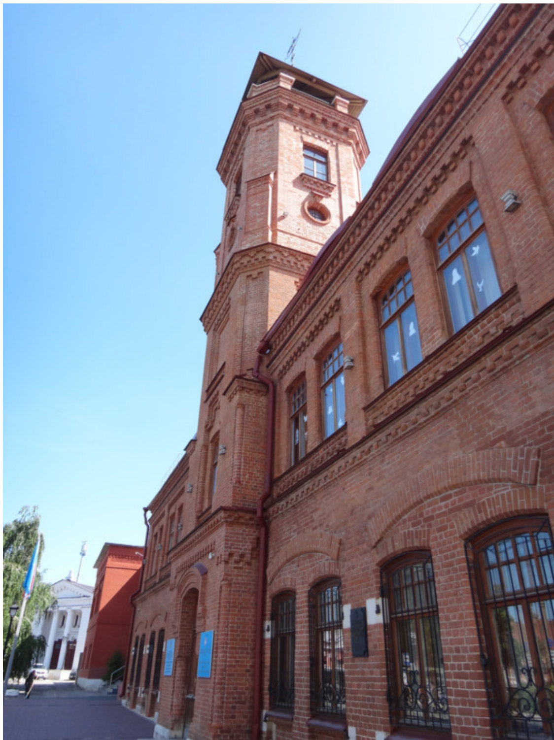
Здание пожарной службы с каланчой (фото автора, 2023 год)
