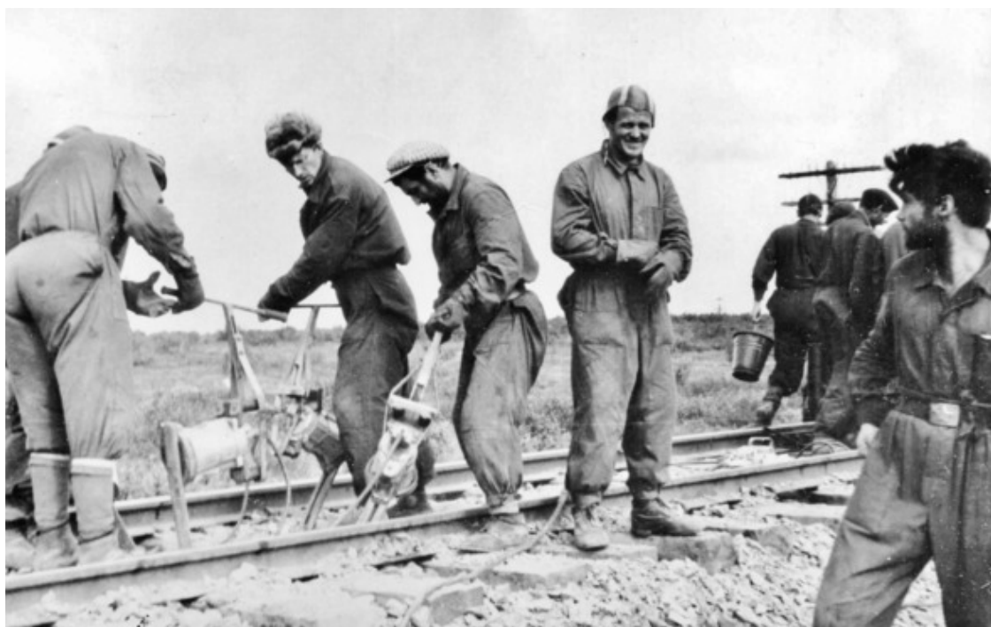
Л. Буравов, В. Бостанджиян, В.Рубцов, В. Боярченко, 1969г., мастера работы на электрошпаловиброподбойке (электрошпуге)
