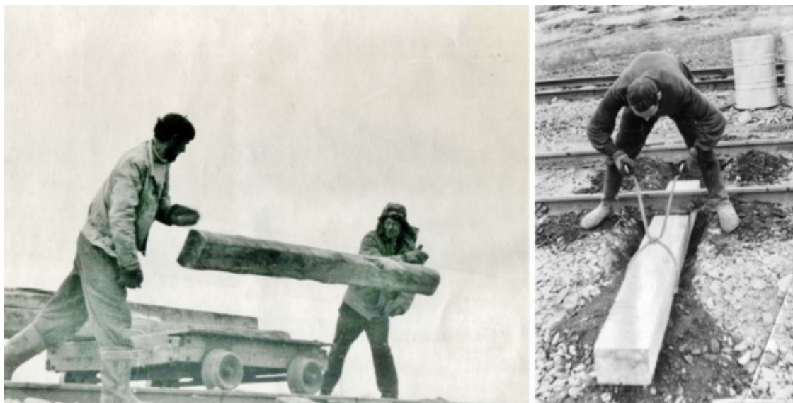
Слева: Слава Грачёв и Лев Буравов. Последняя шпала в воздухе. Пора освободить колею. Справа: ложе для шпалы уже приготовлено. Пора поместить шпалу на своё место
