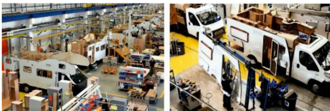
Рисунок 3.15. Слева монтаж стен на заводе бренда «Hymer Group» — «Carado», справа установка стен производства «Hobby».
