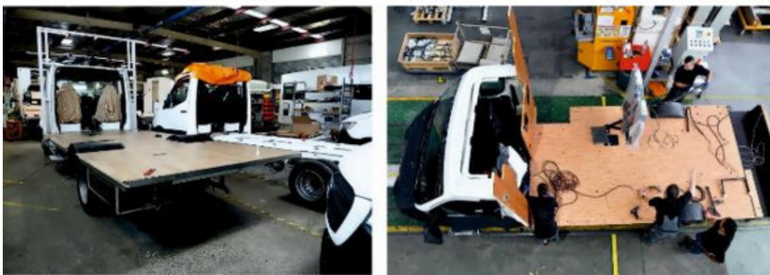
Рисунок 3.10. Готовый пол из сэндвича — панели. Начало монтажа внутреннего оборудования (рама пассажирского дивана уже установлена).
