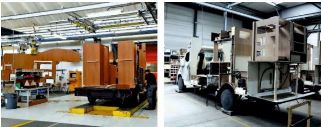
Рисунок 3.13. Слева: монтаж системы отопления, подключение газовой плиты и холодильника. Справа: монтаж кухонной зоны, душевой кабины с туалетом.
