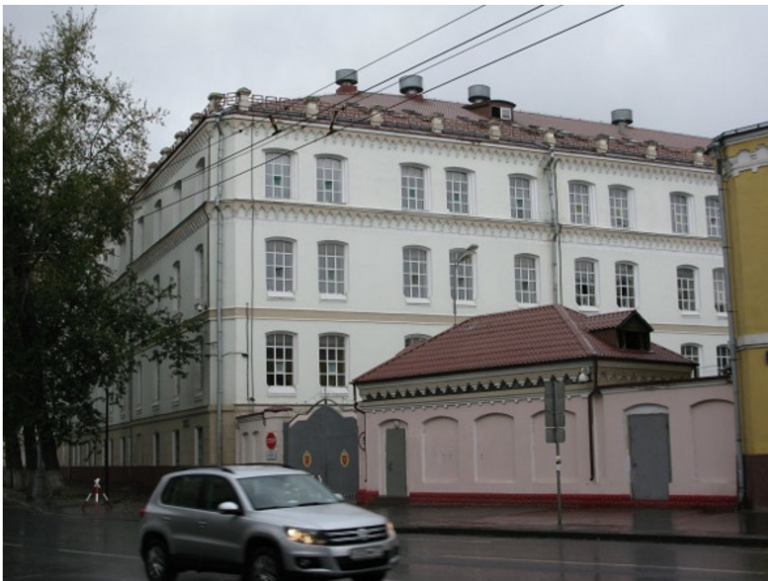
Здание современной казармы. Вид со стороны Подольского шоссе. Фото А. В. Скобкарёва
