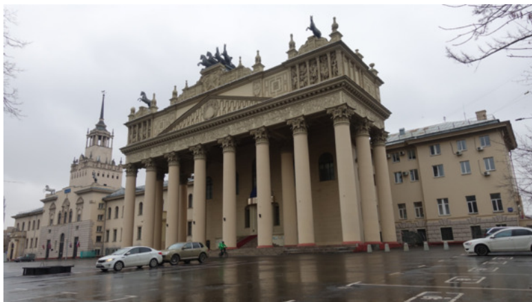
Главное здание с восьмиколонным портиком Центрального Московского ипподрома
