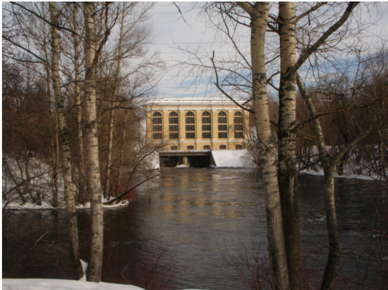
Сходненская ГЭС – выход в реку Сходня
