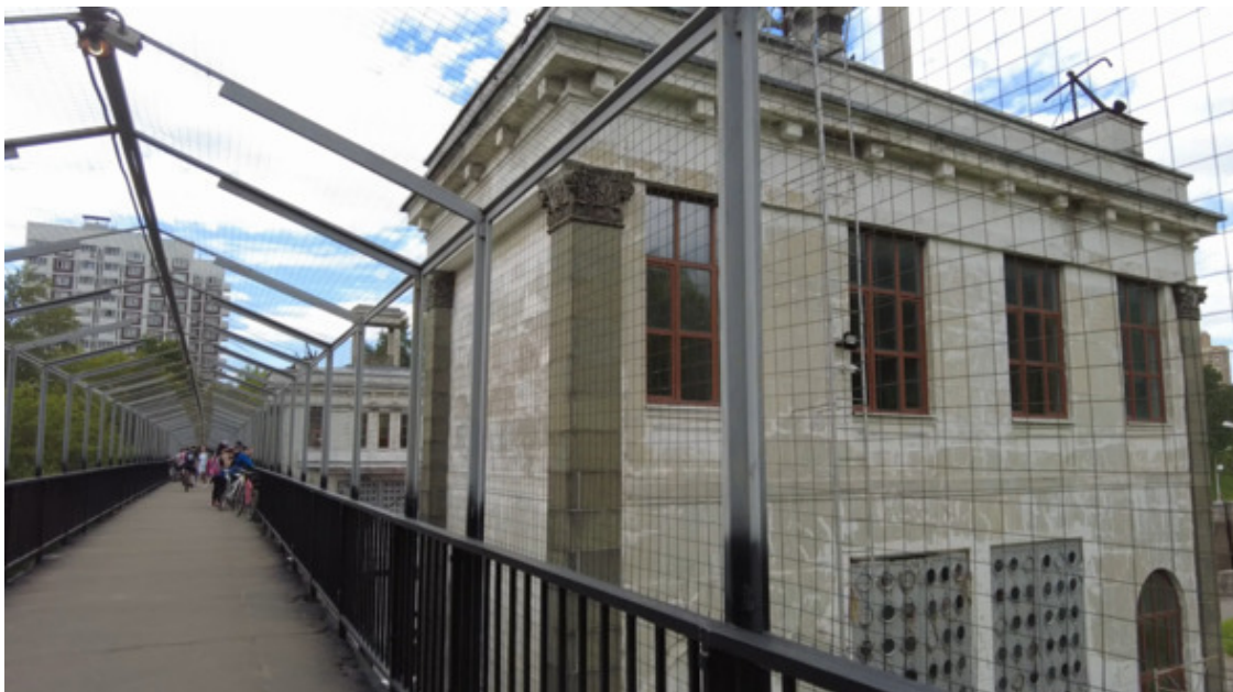
Пешеходный мостик над шлюзом №7 Канала имени Москвы
