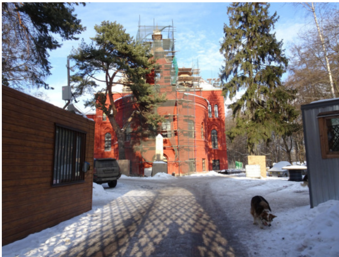
Здание усадьбы частично отреставрировано, но работы продолжаются
