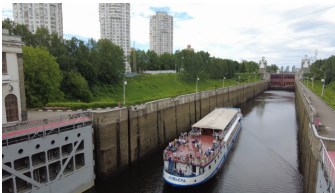
Теплоход зашел в нижнюю камеру шлюза №7 и швартуется к стенке. Заполнение камеры водой пока не началось
