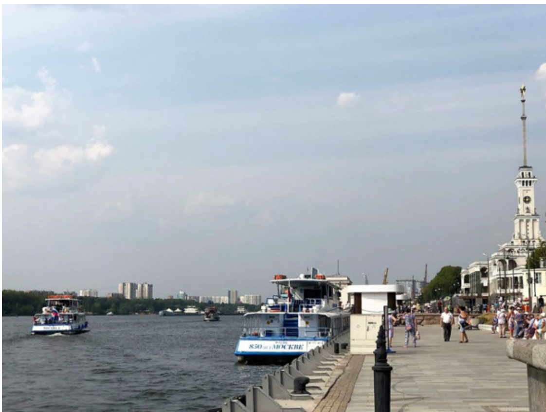
Причалы Северного речного вокзала
