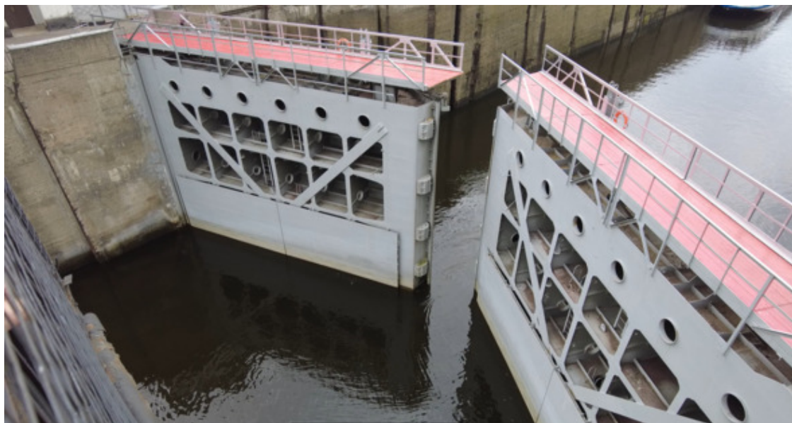
Ворота нижней камеры шлюза №7 закрываются — вид с мостика над шлюзом
