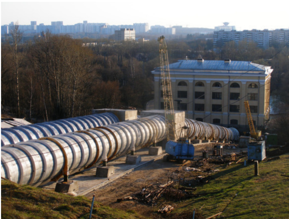
Знаменитые трубы-водоводы Сходненской ГЭС
