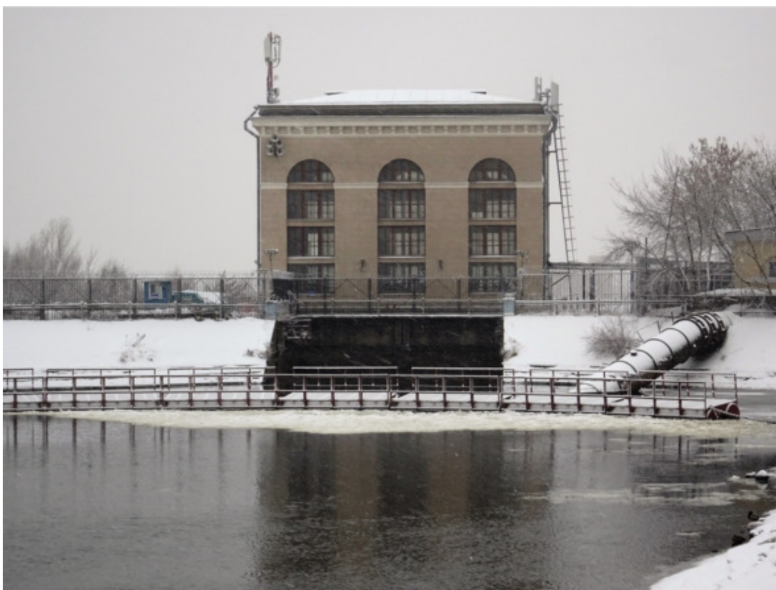
Водоприемник Сходненской ГЭС – с него начинается станция
