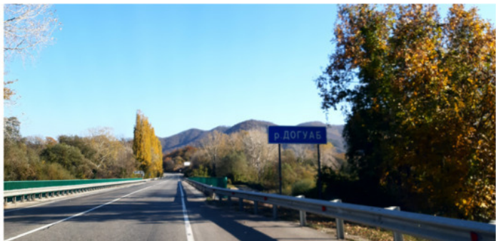
Фото №69. Мост через реку Догуаб
