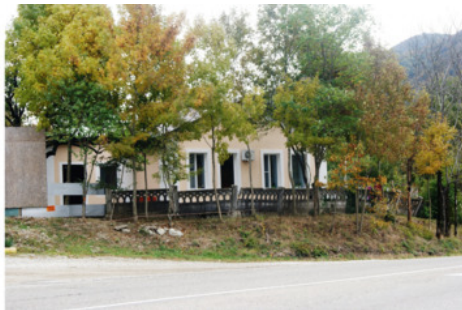
Фото №39. Дом дорожного мастера
