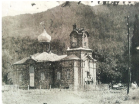
Фото №91. Разрушение церкви в селе Пшада
