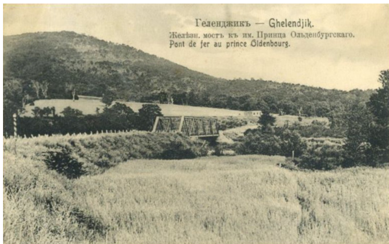
Фото 10. Мост через реку Адерба. 1913 год
