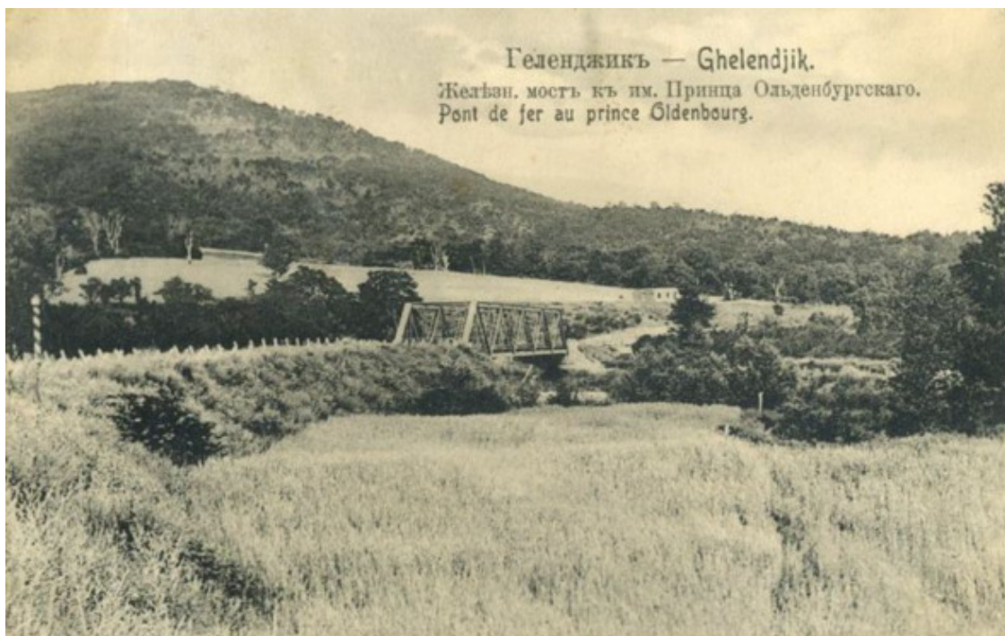
Фото 10. Мост через реку Адерба. 1913 год
