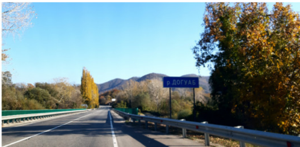
Фото №69. Мост через реку Догуб
