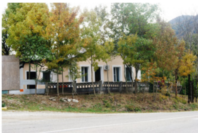
Фото №39. Дом дорожного мастера
