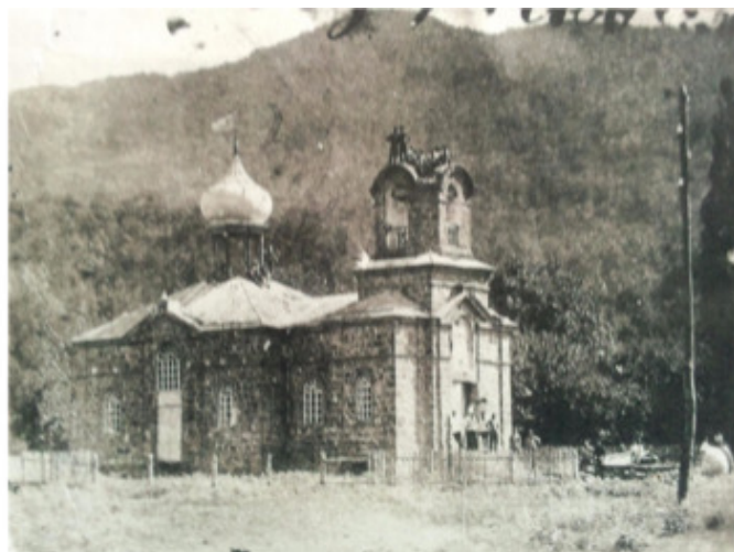
Фото №91. Разрушение церкви в селе Пшада
