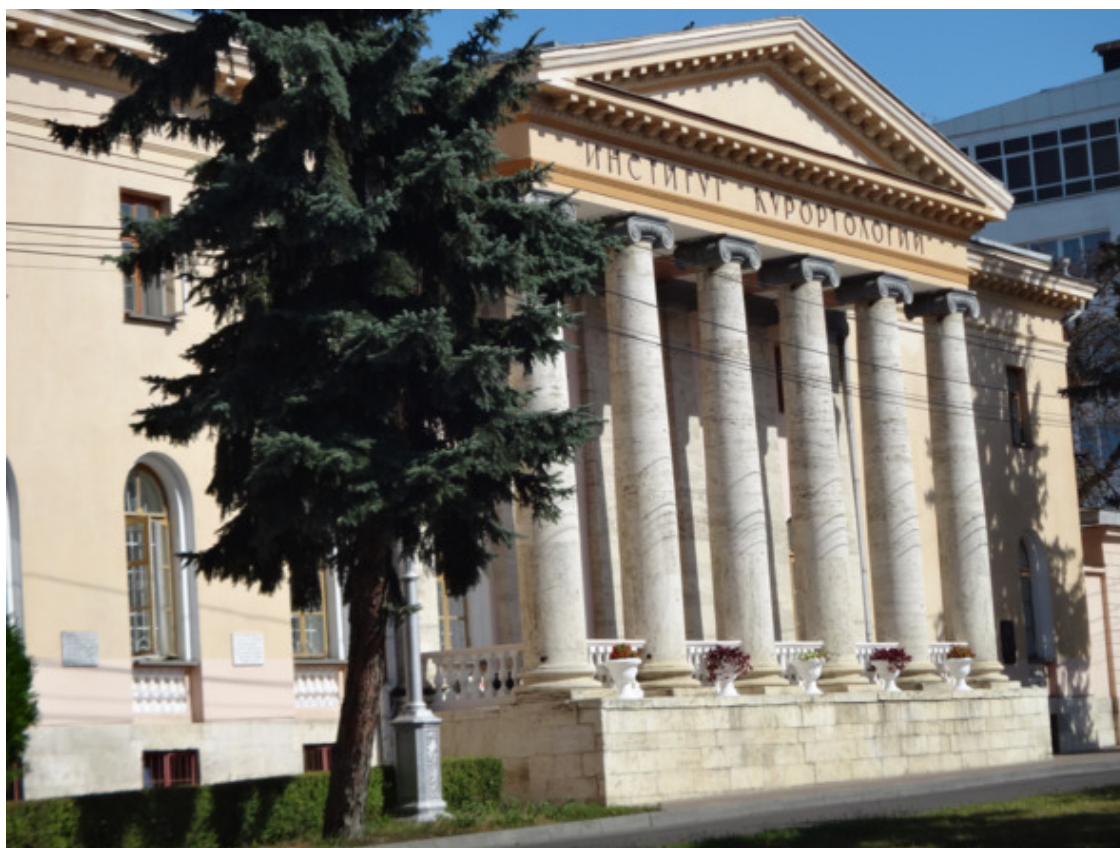
Здание Ресторации (проспект Кирова,30)
