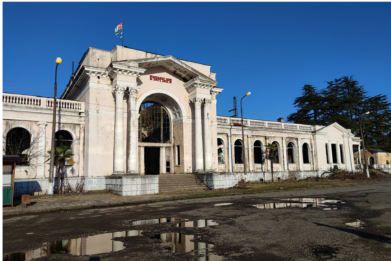
Здание ж/д станции
