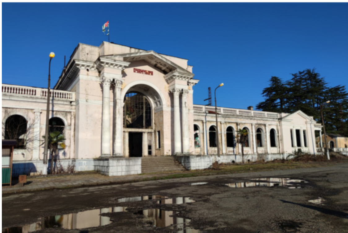
Здание ж/д станции
