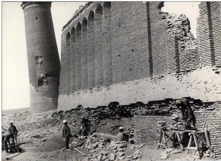
Рис. 7. Укрепление фундаментов западного крыла фасада Рабат-и Малика. 1928 г.
