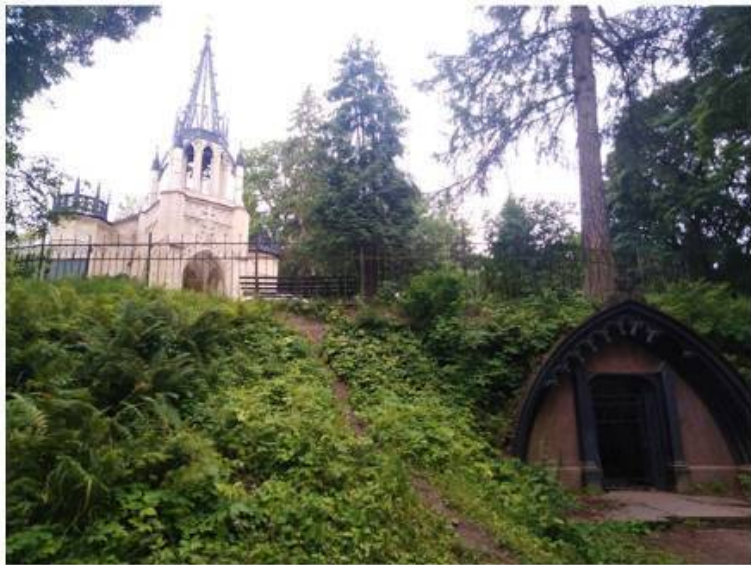
Петропавловская церковь в Шуваловском парке
