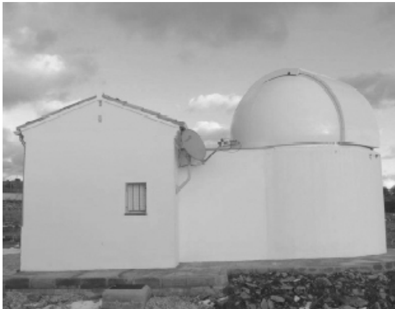
Figura 0.4.- Edificio de TROBAR (OAO)
