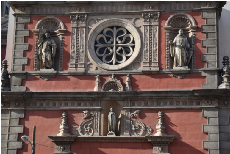
Фасада церкви San José XVIII в.
