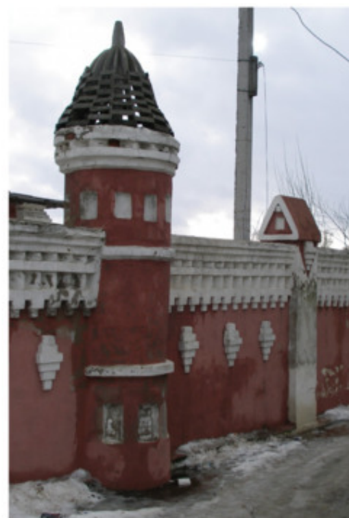
Волоколамск (проезд Ленина, 6), стена с башенками
