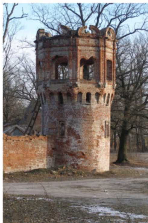
Пушкин, Федоровский городок, башня ограды
