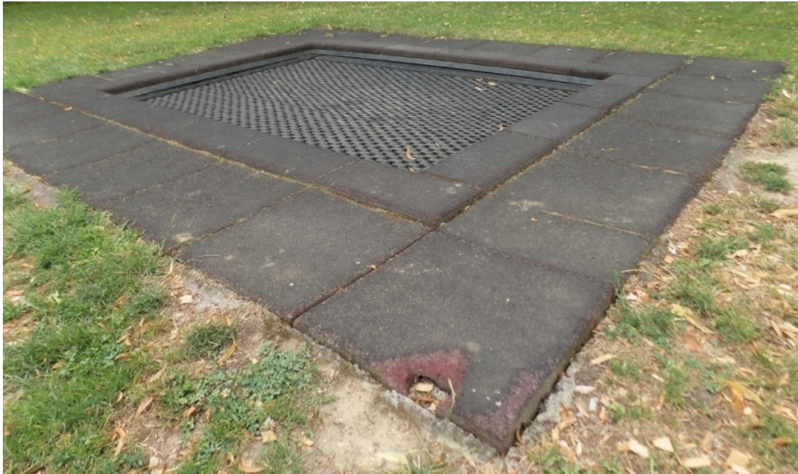
Bild 2: Fallschutzplatten mit Wartungsbedarf. (Quelle: GAO – Gesundheits- und Arbeitsschutz Onischka UG [haftungsbeschränkt].)
