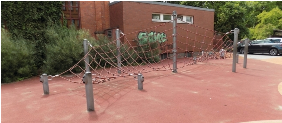
Bild 1: Vor Ort installierter synthetischer Fallschutzbelag muss auch vor Ort nach DIN EN 1177 geprüft werden. (Quelle: GAO – Gesundheits- und Arbeitsschutz Onischka UG [haftungsbeschränkt].)
