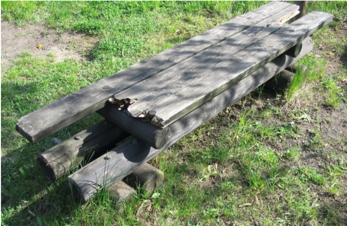
Bild 6: Defekte Sitzbank. (Quelle: GAO – Gesundheits- und Arbeitsschutz Onischka UG [haftungsbeschränkt].)
