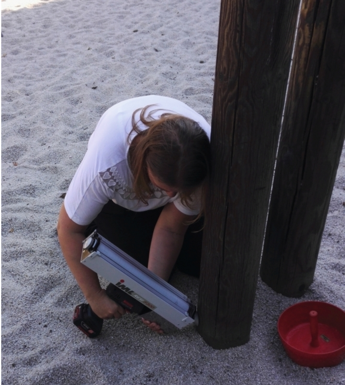
Bild 8: Bohrwiderstandsmessung zur Kontrolle von Fäulnis und Verrottung (Quelle: GAO – Gesundheits- und Arbeitsschutz Onischka UG [haftungsbeschränkt])
