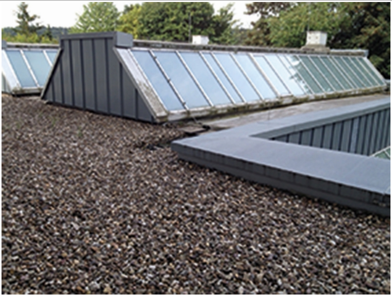
Bild 24: Kiesschicht auf einem nicht genutzten Dach als schwerer Oberflächenschutz (Quelle: Schmidt) Der schwere Oberflächenschutz bietet gegenüber dem
