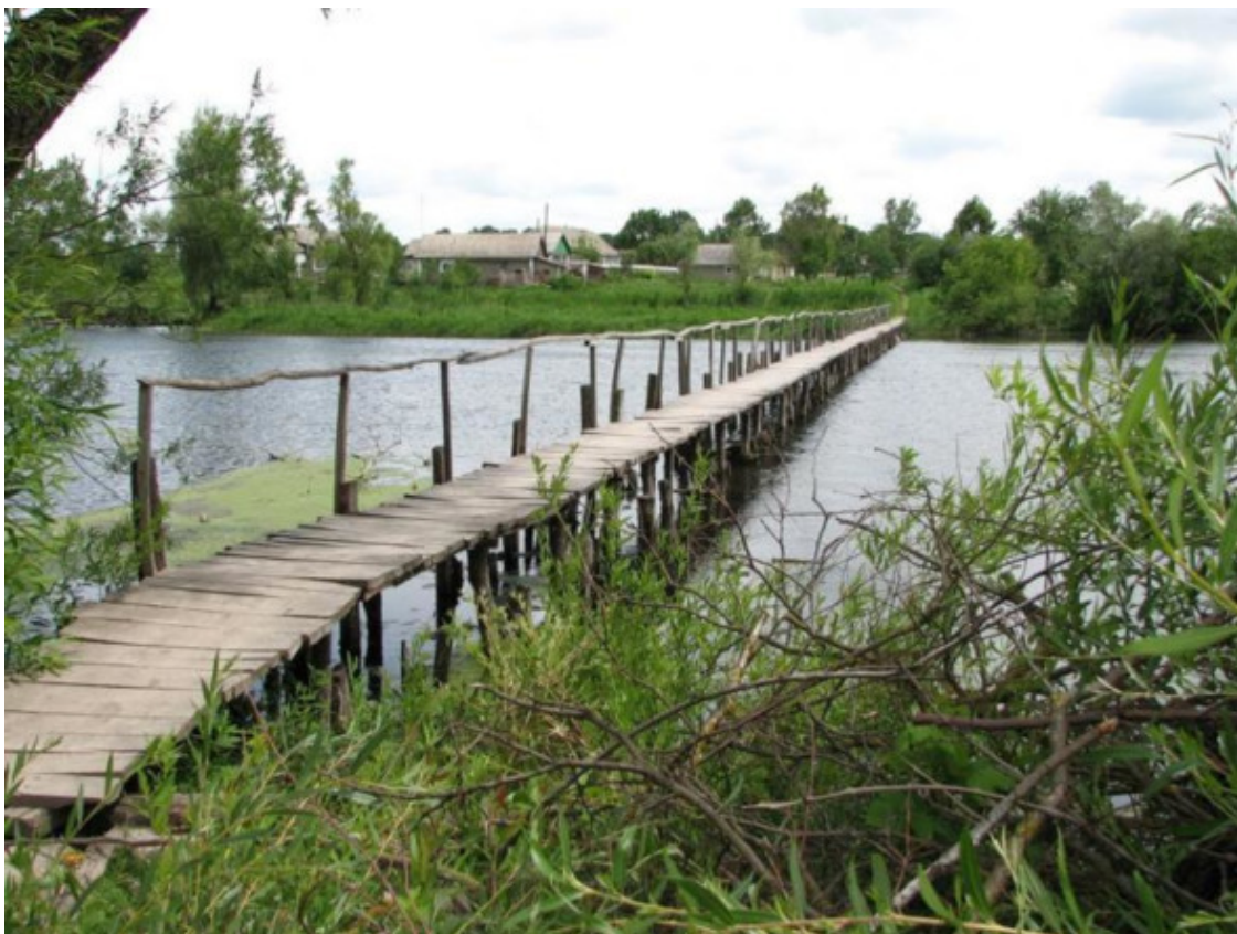
Мосток-лава через пруд
