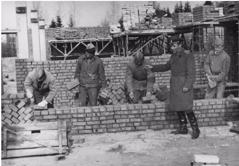
Идёт строительство городка и завода
