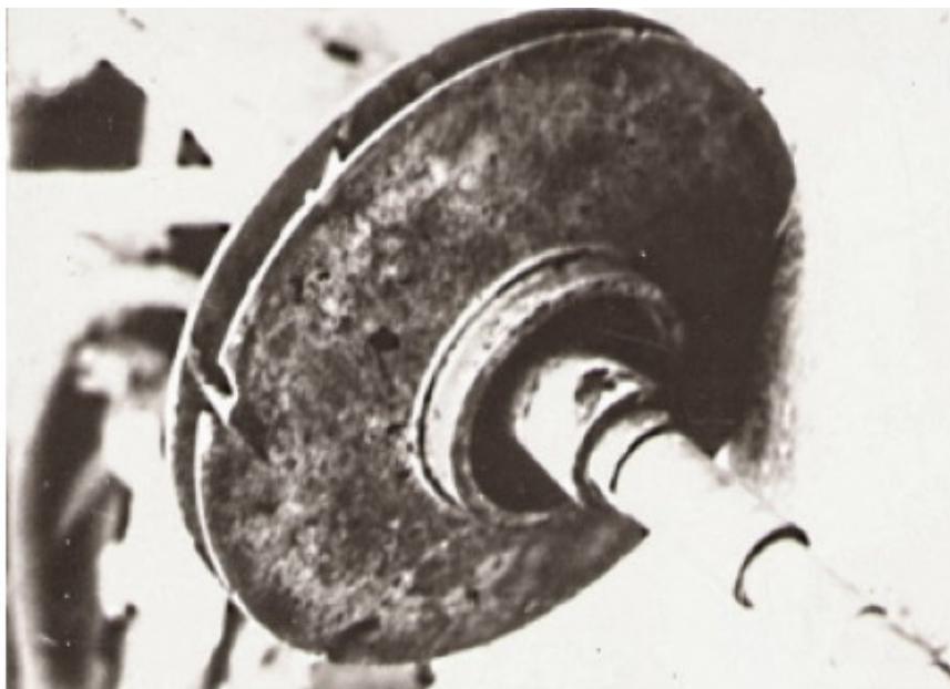
Рис. 1.11. Разрушение выходных кромок лопастей и дисков рабочего колеса насоса при перекачивании воды содержащей твёрдые включения
