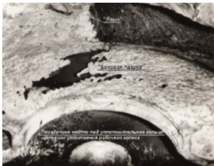
Рис. 1.5. Гидроабразивный износ стенок «боковой пазухи» и «языка» спирального отвода насоса 24НДс (Река Аму-Дарья, насосная станция «Аму-Занг I»)
