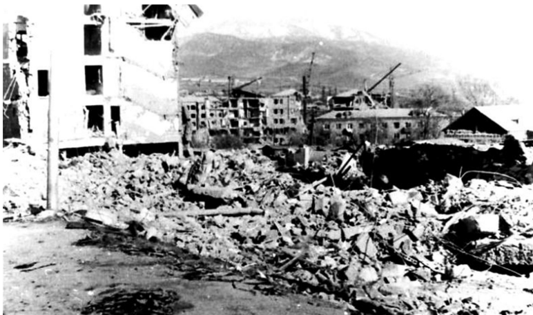
Рис. 2.6. Разрушение зданий в г. Ашхабаде
