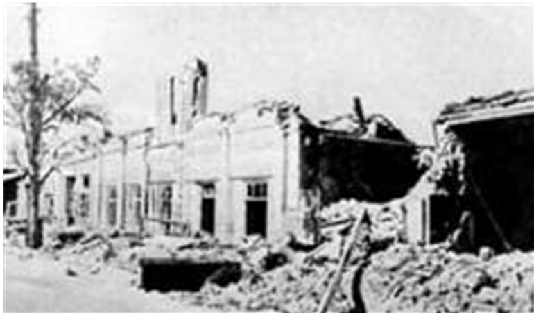
Рис. 2.5. Последствия землетрясения в Ашхабаде
