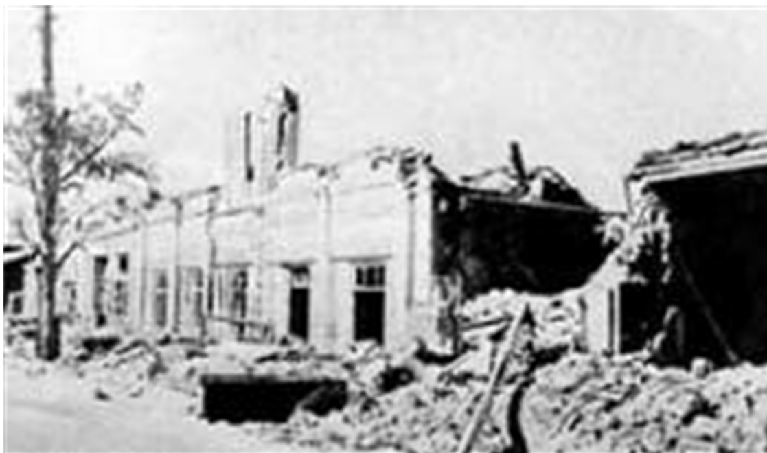
Рис. 2.5. Последствия землетрясения в Ашхабаде
