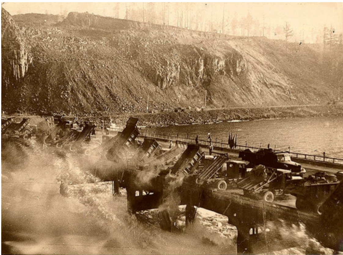
Начало строительства Братской ГЭС
