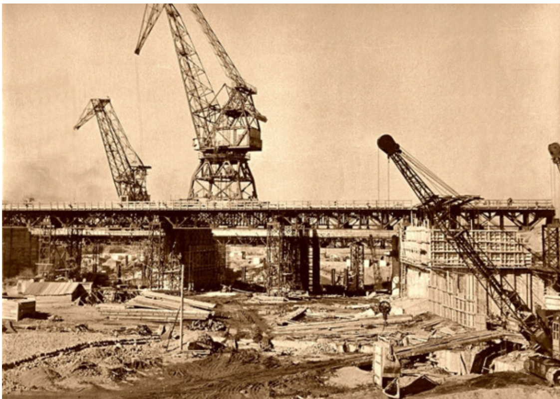
Строительство Иркутской ГЭС
