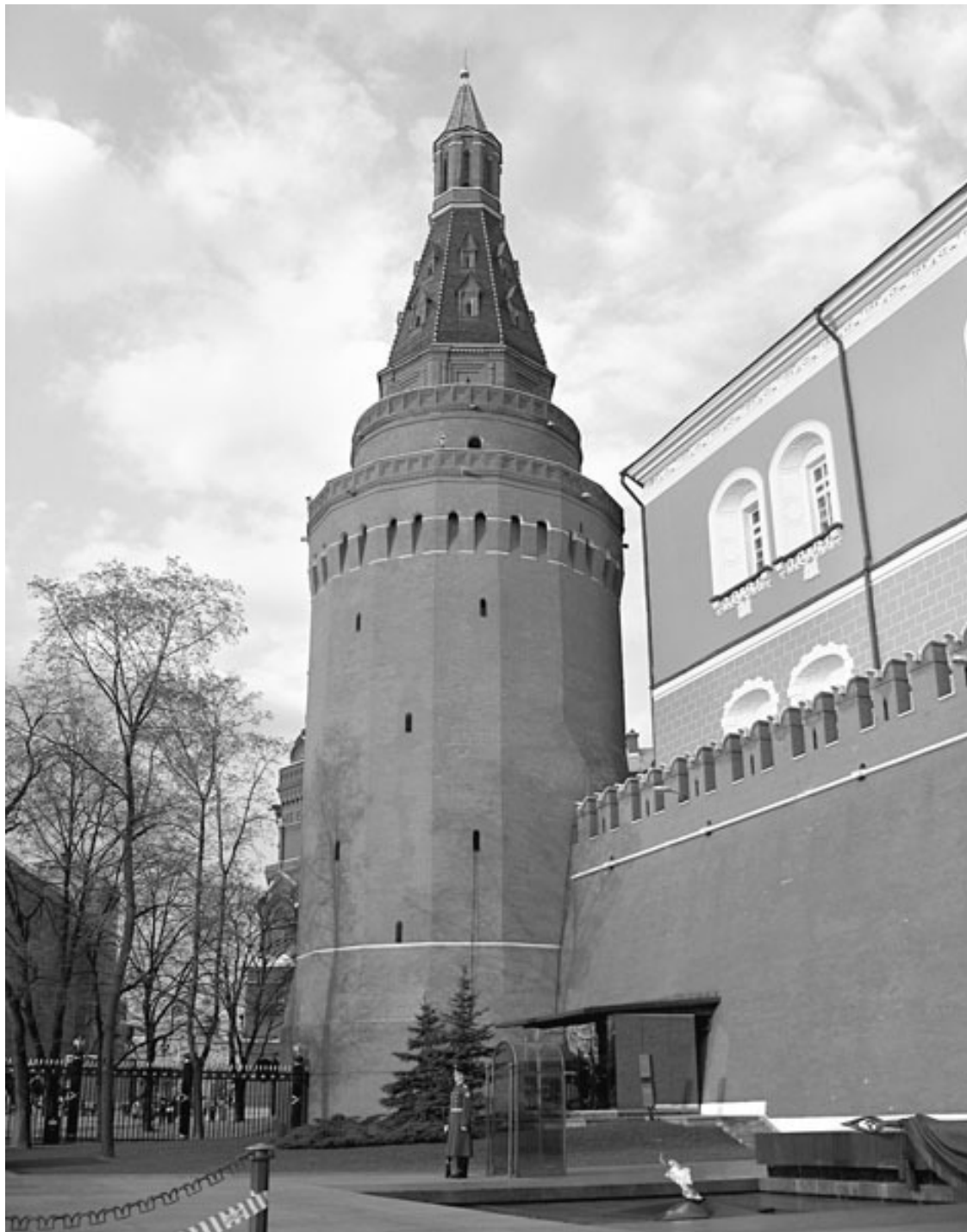
Угловая Арсенальная башня
